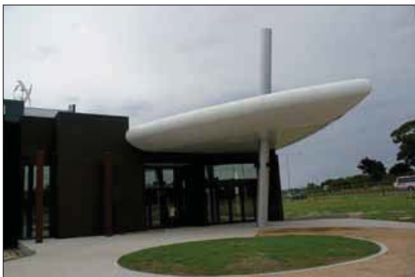
An der Surf Coast sind Umweltschutz und Nachhaltigkeit hohe Werte. Dem entspricht die effiziente Gebäudesystemtechnik mit KNX.
