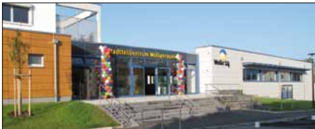
In diesem öffentlichen Gebäude optimieren KNX Funktionen den Energieverbrauch und eine Visualisierung informiert das Publikum über die erreichte Energieeffizienz.
