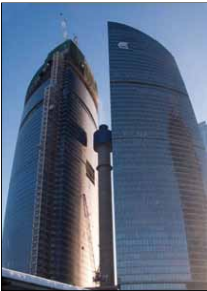
Auf 33 Etagen des „Zapad“ werden in den Räumen der VTB Bank Funktionen der Gebäudetechnik mit KNX gesteuert.
