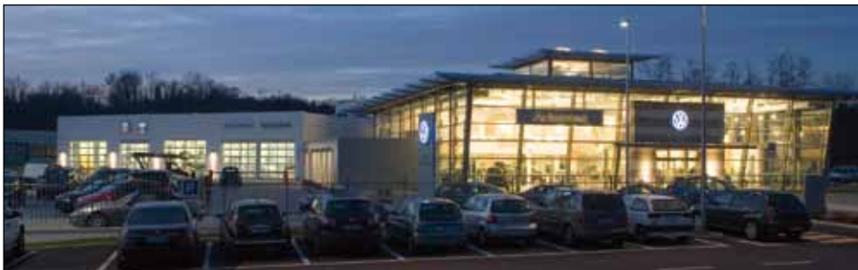
Neues Autohaus von Autoarona in Paruzzaro: Eine KNX Visualisierung führt die Gebäudetechnik von drei Standorten des Autohändlers zusammen.
