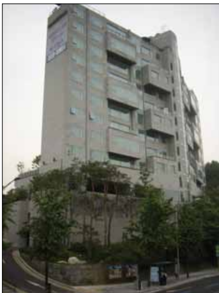
Die Apartments von Mark Hills bieten nicht nur die beste Gebäudetechnik mit KNX, sondern auch ein gigantisches Panorama.
