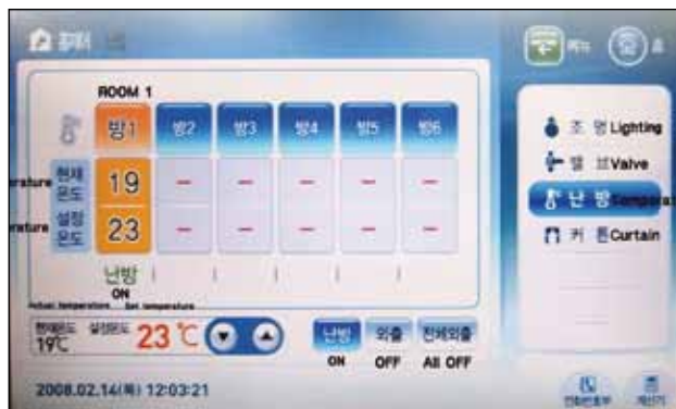
Komfortable Bedienung der KNX Funktionen über zentrales Touch-Panel: Zum Beispiel Menüs für Heizung, Vorhänge und Beleuchtung.
