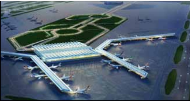
100.000 Leuchten und KNX sorgen im neuen Terminal des Delhi Airport für ein effizientes Licht
