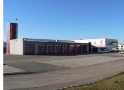
Bild 4. Die neue Feuerwehrzentrale Obergrafendorf: Vollständig mit KNX automatisiert und überwacht. Quelle: HTL St Pölten
