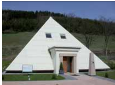
Bild 3. Alle Fenster verfügen über elektrische Beschattung und Öffnung sowie Fensterkontakte und sind damit vollständig in die Vernetzung eingebunden
