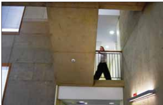
Bild 2. Energieeffizienz 2: Viel Tageslicht und Präsenzmelder für die Beleuchtung.
