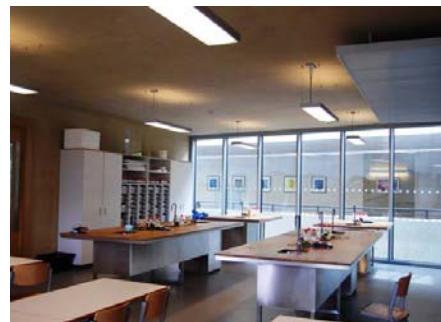
Bild 2. Energieeffizienz 1: Konstantlichtregulierung durch KNX in den Labors. Quelle: Andromeda
