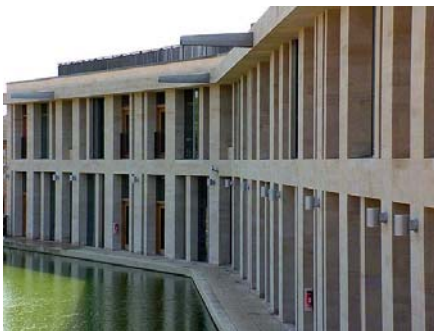
Bild 1. Das SciTec Zentrum der Oundle School vereint Wissenschaft, Kunst und Technik und wurde mit zukunftsgerichteten nachhaltigen Technologien wie KNX erbaut. Quelle: Andromeda
