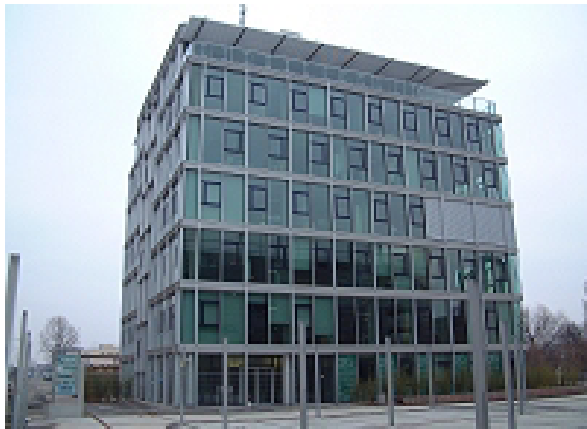
Das Verwaltungsgebäude mit der Glasfassade
