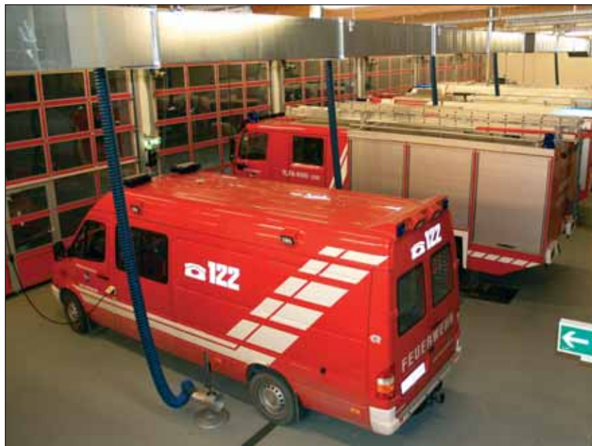
Bild 1. Blick in die Fahrzeughalle der neuen Feuerwehrzentrale Obergrafendorf
