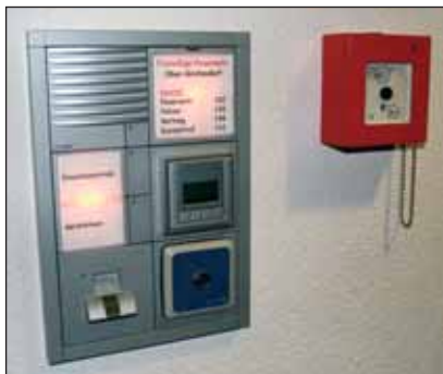
Bild 2. Dank der Vernetzung der Gewerke werden bei der Zutrittskontrolle per Fingerprint die Tore geöffnet sowie die Beleuchtung eingeschaltet.
