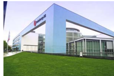
Bild 4. Der Hauptsitz der Salzburg AG, in dem die KNX-Straßenbeleuchtungs-Steuerung realisiert wurde. Quelle: Schäche
