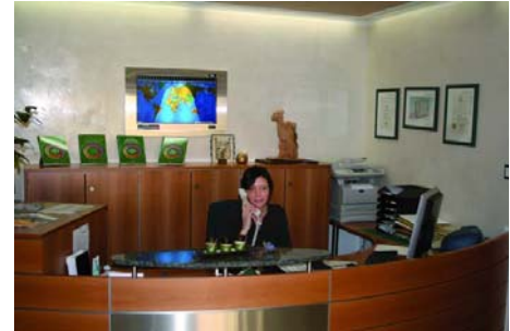
Bild 2. Rezeption mit dem zentralen Touchpanel mit Zugriff auf alle Anlagen. Quelle: Kuhlmann
