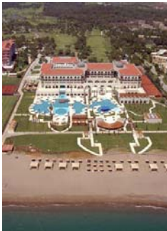
Bild 1. Die Seldschukische-Architektur gibt dem Kempinski The Dome an der türkischen Riviera seine besondere Note. Quelle: Hitit
