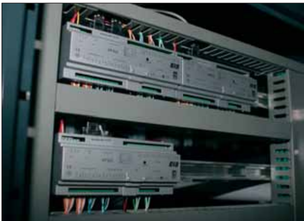
Bild 3. Mit den KNX-Audio-Komponenten ist es möglich, in jedem Raum die Tonquellen auszuwählen sowie Klang und Lautstärke zu verändern
