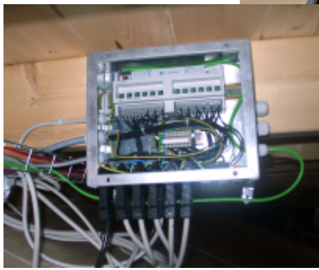
Lingg & Janke Duo-Schaltaktoren am ecobus-Kabel
